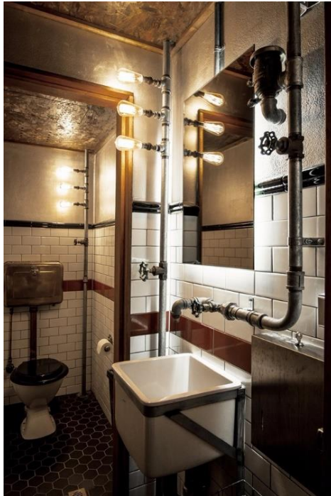
Brew Restaurant Doppio Malto - Verona: realizzazione impianti sanitari e di climatizzazione
