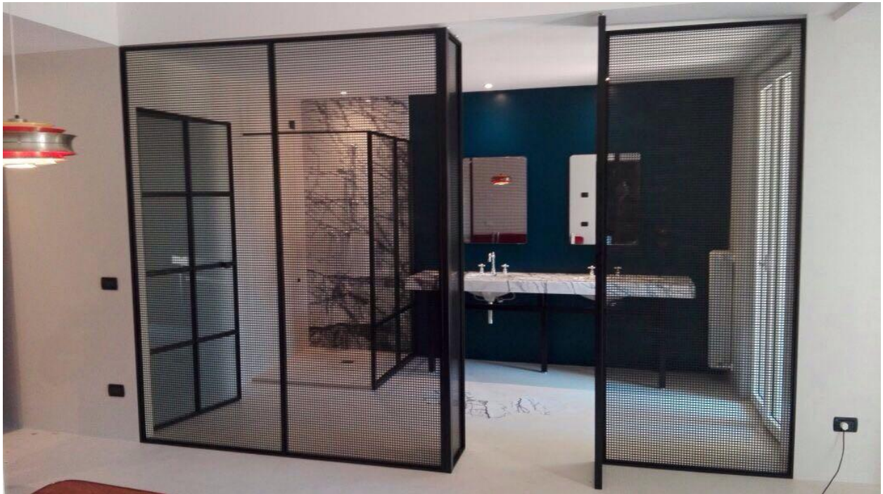
Hotel Trieste - Verona: realizzazione impianti sanitari e di climatizzazione delle stanze
